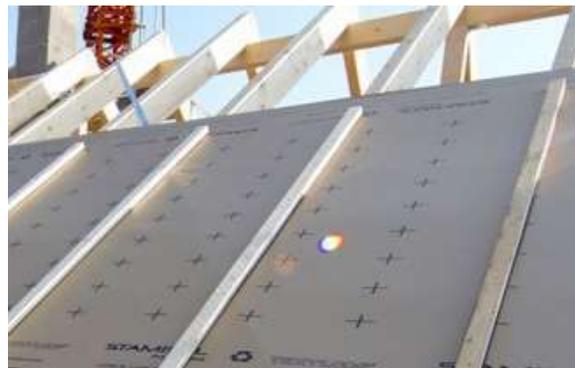
Abbildung 2: Regensicheres Unterdach (nach ZVDH)
