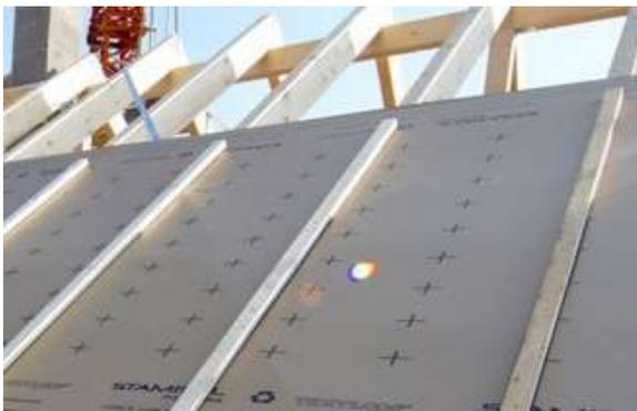
Abbildung 1: Regensicheres Unterdach (nach ZVDH)
